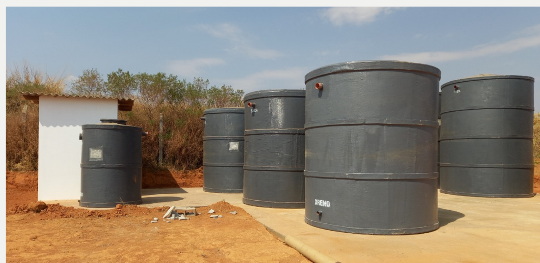
Estação de Tratamento de Esgoto - ETE Fonte: O autor
