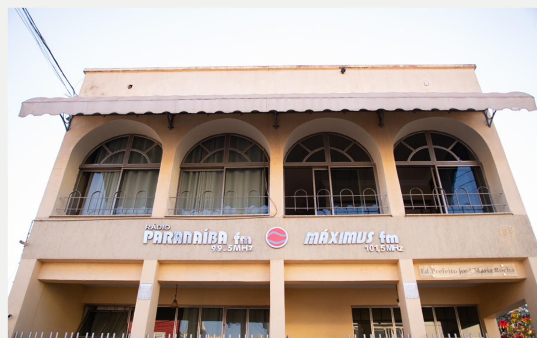
Edifício das Radios Paranaíba e Máximus FM Fonte: o autor
