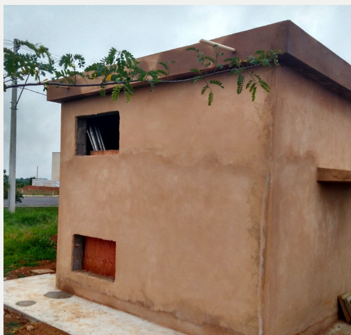
Obras da Cabine de Energia. Fonte: O autor.
