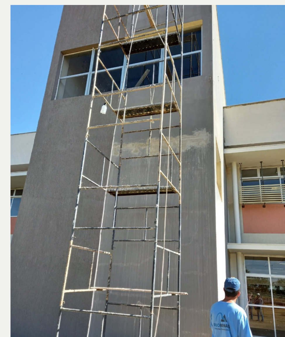
Reforma do Pavilhão de Aulas. Fonte: O autor.
