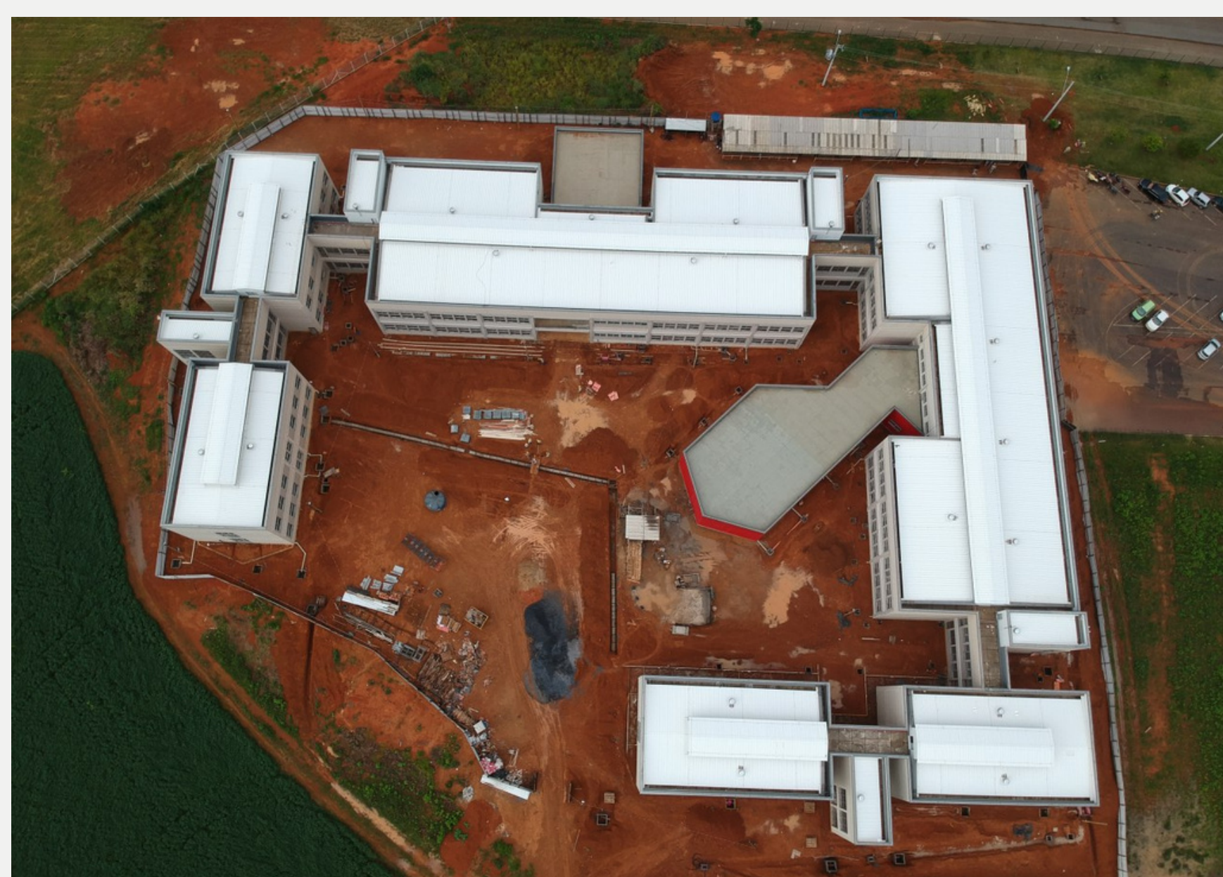
Construção do edifício de Laboratórios de Ensino Fonte: Alcance Engenharia
