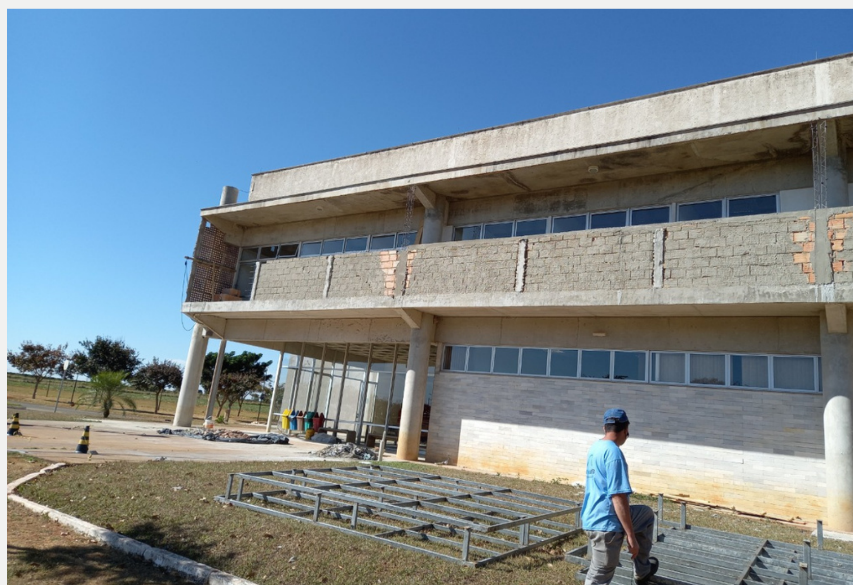
Obra de reforma da Biblioteca Central. Fonte: O autor.
